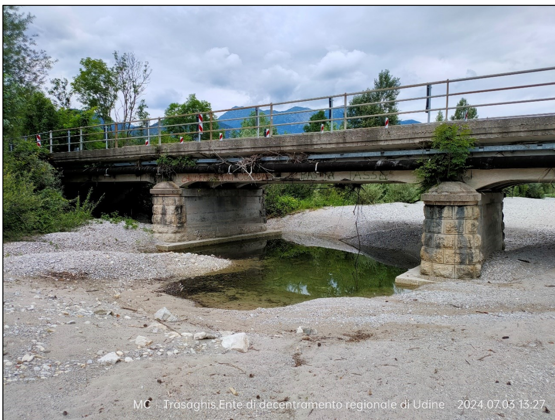
Figura 5 Vista ponte lato valle.
