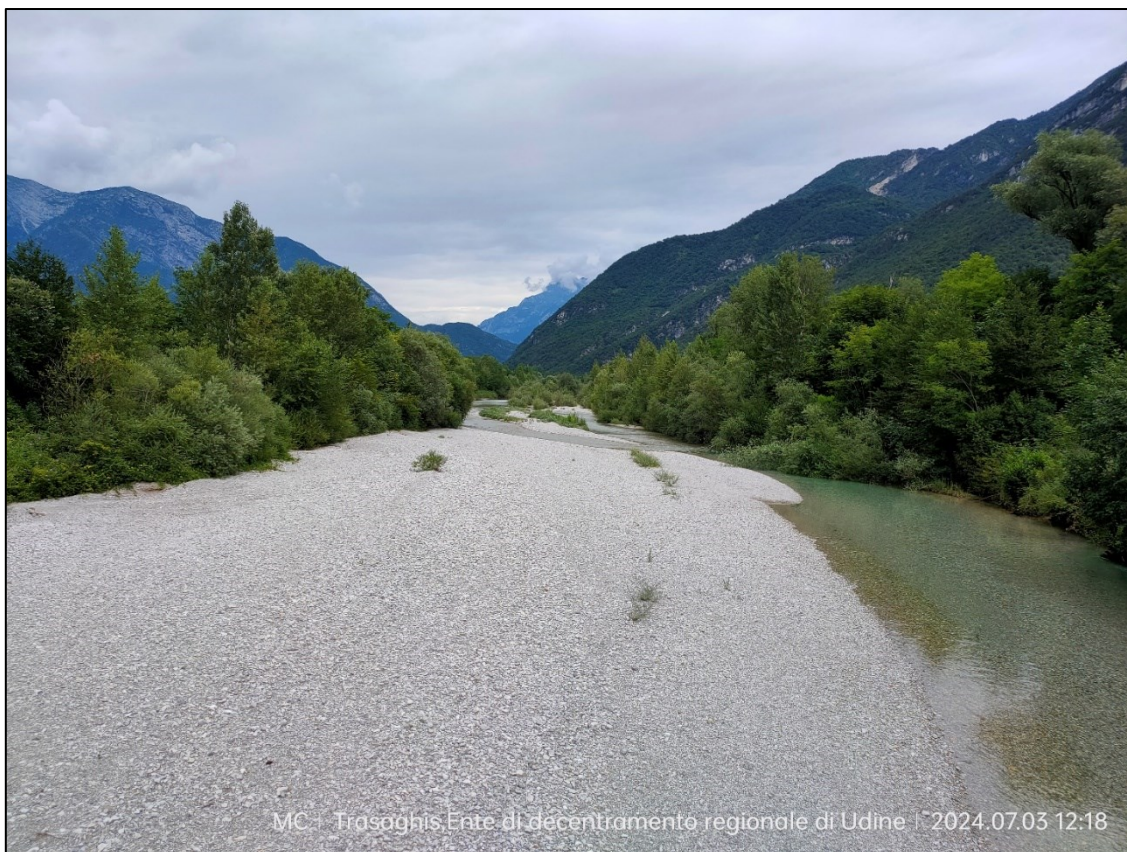
Figura 2 Alveo t. Leale a monte del ponte SR UD 41.
