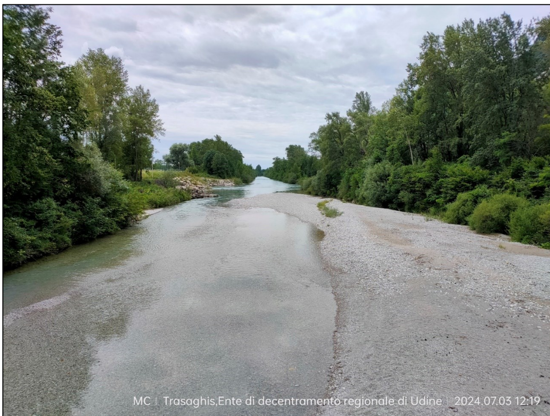
Figura 3 Alveo t. Leale a valle del ponte SR UD 41.
