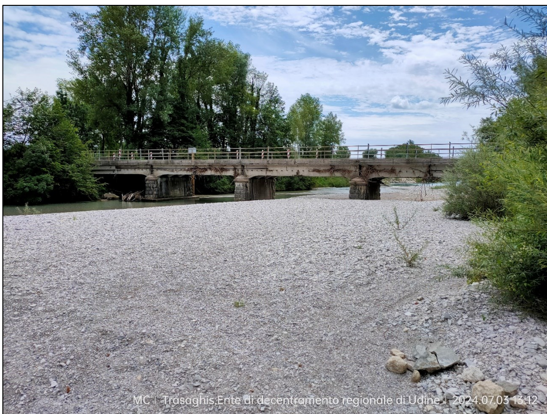
Figura 4 Vista ponte da monte.
